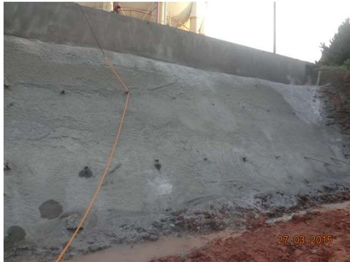
Figura 3. Talude estabilizado com solo grampeado próximo às esferas.
