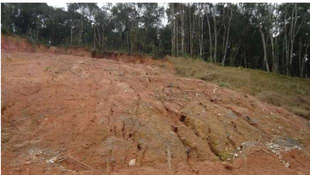
Figura 2. Talude rompido – Notar grande quantidade de material deslocado.
