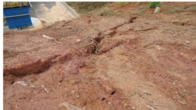
Figura 6. Trincas observadas no terreno indicando continuidade da movimentação.
