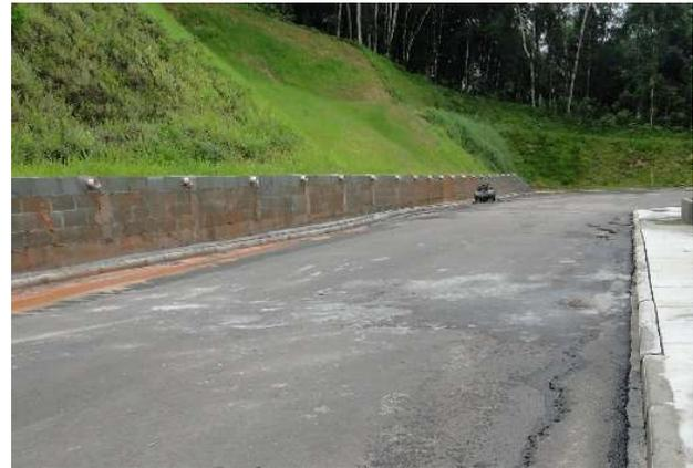
Figura 5. Trincas no pavimento da ETE ocorridas em função do deslocamento do maciço.
