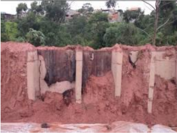
Figura 5. Contrafortes de montante do paramento.
