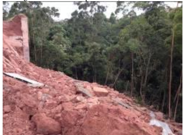
Figura 3. Material mobilizado após ruptura.
