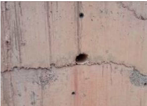
Figura 1. Detalhe do sistema de drenagem da contenção.
