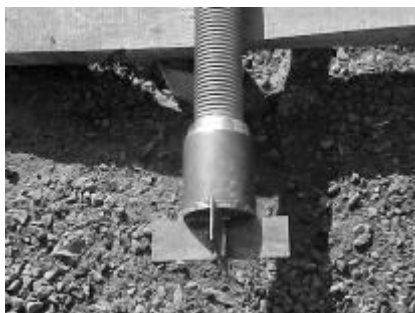
Figura 4. Detalhe das aletas na ponta do tirante.
